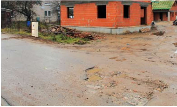
UAB „Trakų vandenys“ išardytas Naujosios gatvės asfaltas prie statomo namo. Toliau kairėje – gamtinių dujų dėžutė. Jų prisijungimas prie trasos – išardytas asfaltas ir užpilta žemėmis duobė
